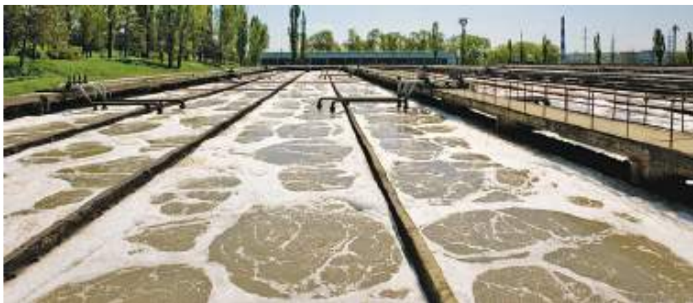
Рис. 101. Очистные сооружения муниципия Кишинэу, производительностью 6 600 м 3 /час
