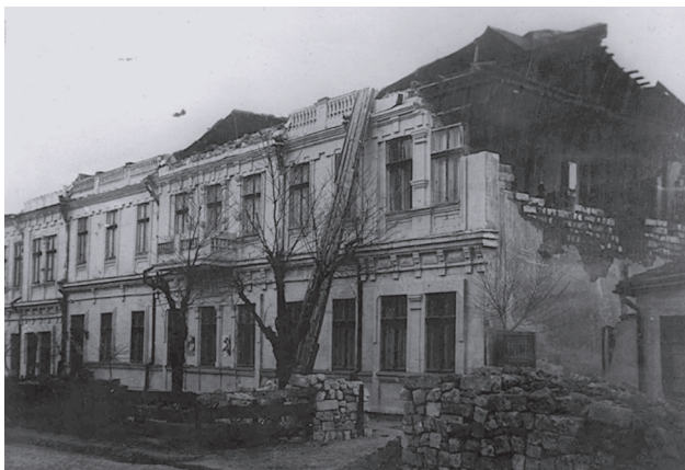
Рис. 20. Здание в Кишинэу, разрушенное землетрясением 10 ноября 1940 г.
